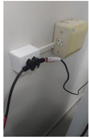
Figuras 08 e 09: Instalação de tomada dupla externa, para excluir o uso de tês.
