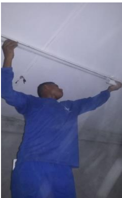
Figuras 01 e 02: Instalação de luminárias na sala do TI;
