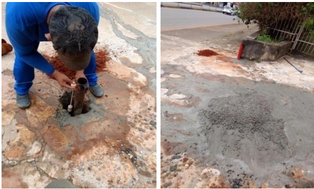
Figuras 01 e 02: Foi feito a fixação de hastes para instalação de correntes, protegendo a área da saída de resíduos;
