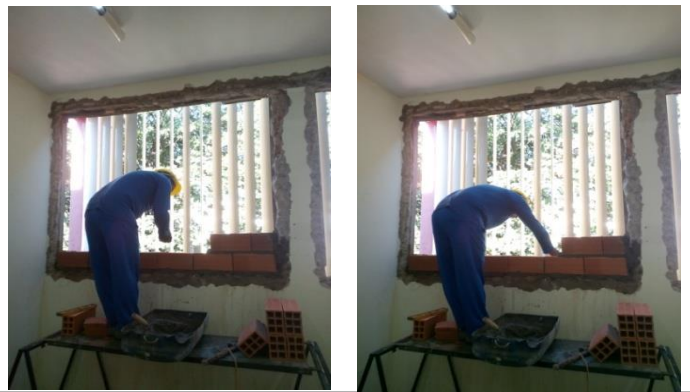
Figuras 03 e 04: Fechamento de abertura em alvenaria;
