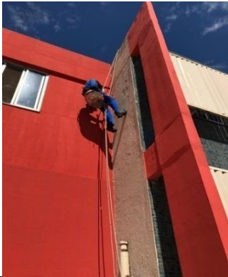
Figura 01: Remoção do revestimento em destacamento na fachada;
