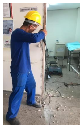
Figuras 02: Remoção do portal;
