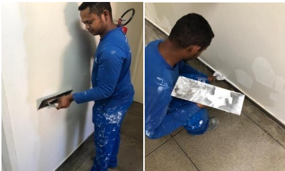
Figuras 09 e 10: Manutenção em pintura nas paredes do corredor térreo, aplicação de massa pva;
