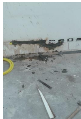
Figuras 04 e 05: Instalação de mangueiras corrugadas para passagem de circuito elétrico;
