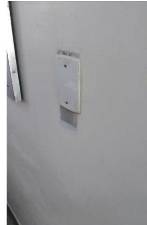
Figura 10 e 11: Remoção de telefone em desuso e a instalação de uma tampa cega.
