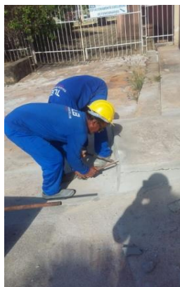
Figuras 01 e 02: Abertura de tampa de caixa de esgoto para solucionar vazamento de esgoto na rua;
