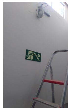
Figura 06: Instalação de luminária tipo tartaruga na escada da diretoria;
