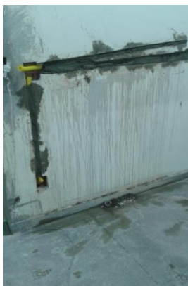
Figuras 04 e 05: Instalação de mangueiras corrugadas para passagem de circuito elétrico;
