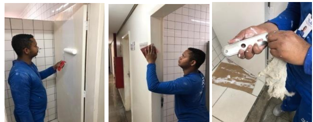
Figuras 02, 03 e 04: Primeiro foi feito o lixamento na porta e no portal, em seguida foi aplicado a tinta e por último o espelho da fechadura foi instalado já higienizado;
