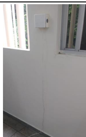
Figura 04: Foram removidas todas canaletas;
