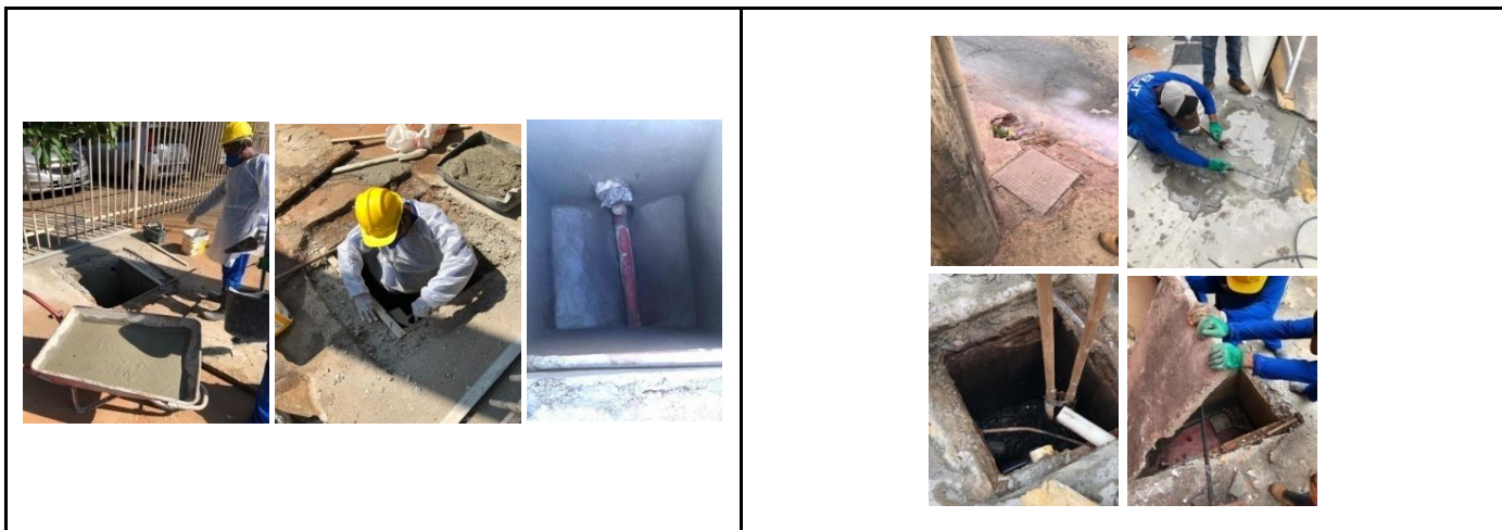
Figuras 10, 11 e 12: Após o assentamento de tijolos nas paredes da caixa de esgoto, foi feito o reboco;
