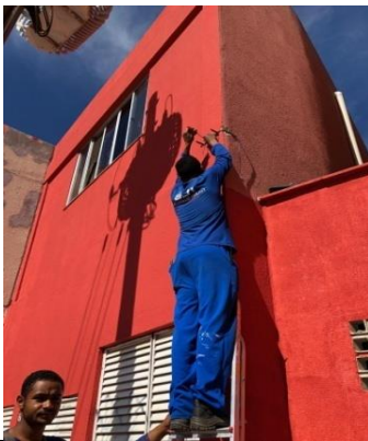
Figura 01: Finalizando o parafusamento dos refletores na fachada;
