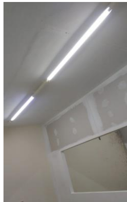
Figuras 01 e 02: Instalação de luminárias na sala do TI;
