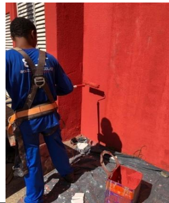
Figura 02: Finalizando processo de manutenção em pintura na fachada frontal da unidade;
