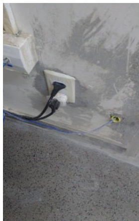
Figuras 04 e 05: Instalação de tomada dupla para funcionamento da impressora do corredor;
