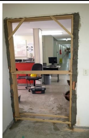
Figuras 03: Instalação do novo portal em argamassa.
