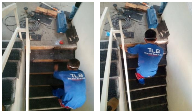
Figuras 05 e 06: Instalação do piso antiderrapante tipo moeda;
