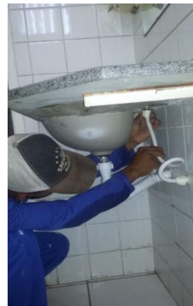
Figura 06: Troca de engate na pia do sanitário feminino do 1º andar;
