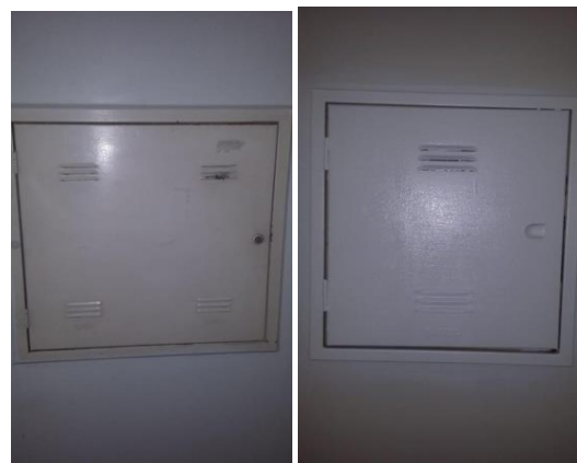
Figuras 04 e 05: Manutenção em pintura nas tampas dos quadros de energia;
