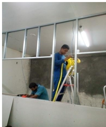
Figuras 05: Individualização do circuito de iluminação da sala do TI;
