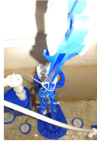
Figura 15: Caixa acoplada no vaso sanitário apresentava problema na descarga, foi feito então um ajuste técnico na corrente de descarga.
