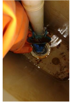
Figura 07: Ajuste em caixa acoplada do banheiro feminino de doadores.
