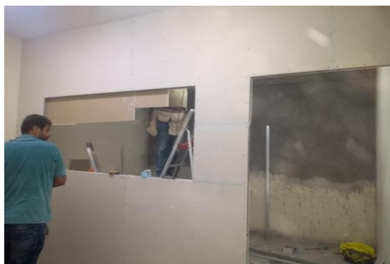
Figuras 04: Finalização da divisória em gesso acartonado na sala do TI;
