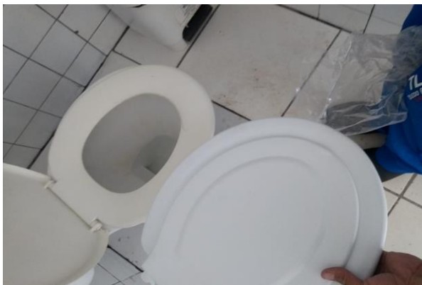
Figura 04: Troca do assento no sanitário feminino;
