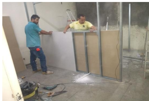
Figuras 03: Fechamento da divisória em gesso acartonado;
