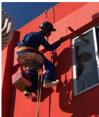
Figura 01: Fachada da unidade passando pelo processo de manutenção em pintura;
