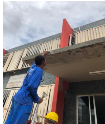
Figura 03: Recuperação da marquise, aplicação de argamassa para regularizar a superfície;
