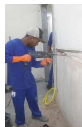
Figuras 06 e 07: Abertura de rasgo em parede para passagem de mangueira corrugada;
