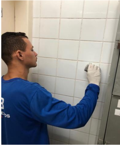
Figura 07: Aplicação de rejunte no revestimento no sanitário;
