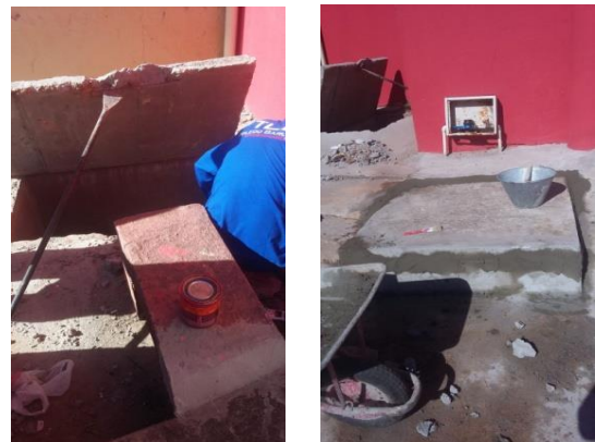
Figuras 03 e 04: Após resolução de esgoto em vazamento foi lacrado as caixas de esgoto;
