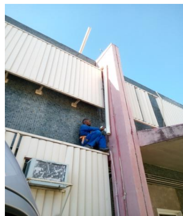
Figura 05: Instalação do desvio da água da calha;
