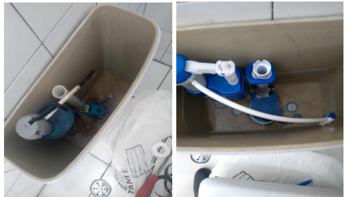
Figuras 02 e 03: Troca do kit de caixa acoplada;
