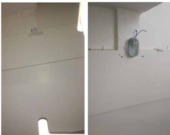
Figuras 04 e 05: Instalação de mangueiras corrugadas para passagem de circuito elétrico;
