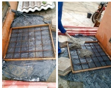
Figuras 03 e 04: Execução de tampa para caixa de esgoto;
