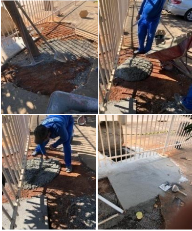
Figuras 11, 12, 13 e 14: Após remoção da calçada em recalque, foi feito a concretagem do novo pavimento;
