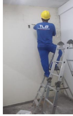
Figura 11 e 12: Abertura de rasgo para passagem do dreno do ar condicionado..
