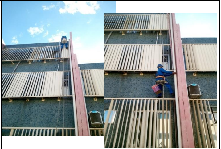
Figuras 11 e 12: Remoção dos canos inutilizados da fachada posterior.
