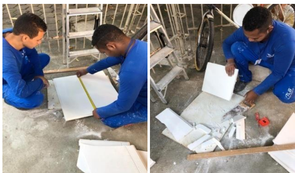
Figuras 06 e 07: Ajuste nas medidas da placa gesso, para reparar o forro;
