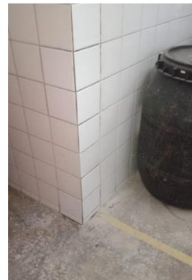
Figuras 03 e 04: Substituição de revestimentos quebrados no abrigo de resíduos;
