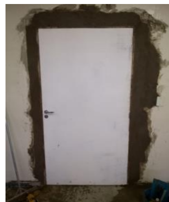
Figura 02: Instalação de porta na recepção de doadores;
