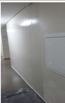
Figura 01: Aplicação do fundo preparador no corredor térreo;
