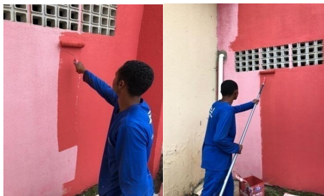
Figuras 01 e 02: Fachada da unidade passando pelo processo de pintura;
