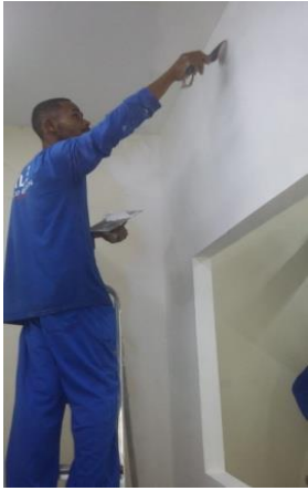
Figura 09 e 10: Aplicação de massa pva na sala do TI;
