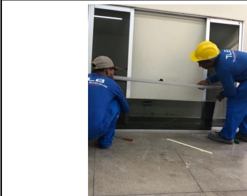
Figura 01: Desparafusamento da janela para que possa ser feita sua retirada;
