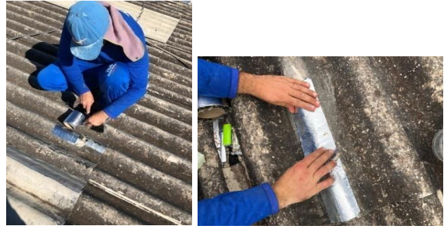
Figuras 08 e 09: Manta asfáltica foi aplicada nas fissuras das telhas.
