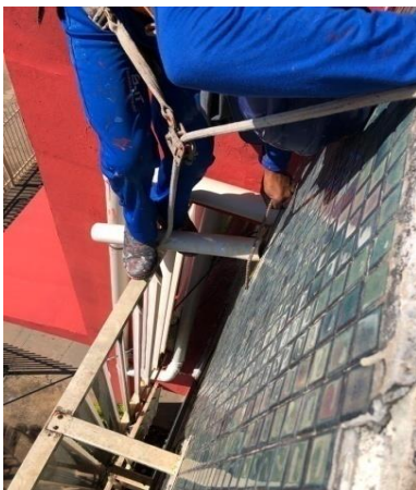
Figura 03: Remoção dos canos excedentes na fachada, tubulação proveniente do sistema extravasor da calha;
