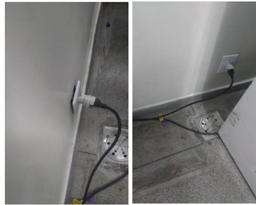
Figuras 07 e 08: Estava solto o espelho da tomada, foi feito a manutenção.
