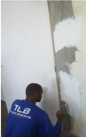
Figura 07 e 08: Aplicação de massa pva na sala do TI;
