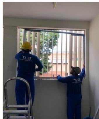
Figura 02: Remoção da esquadria;
