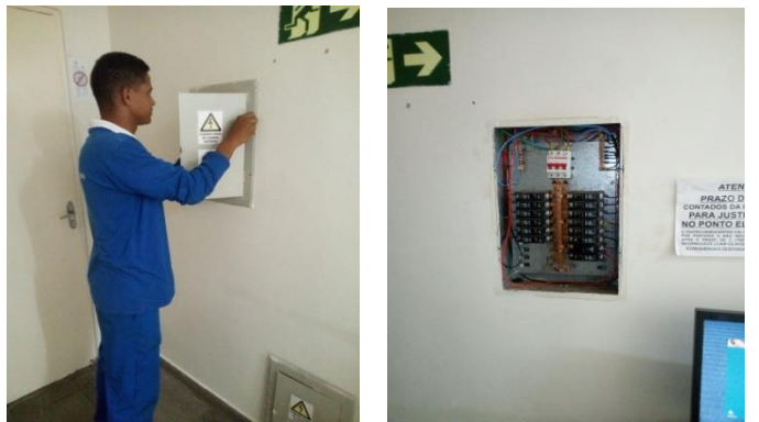
Figuras 07 e 08: Instalação do circuito elétrico para ar condicionado do auditório;
