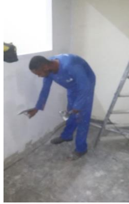
Figura 08 e 09: Aplicação de massa pva na sala do TI;
