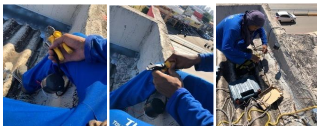
Figuras 01, 02 e 03: Instalação da fotocélula para iluminação do refletor na fachada;
