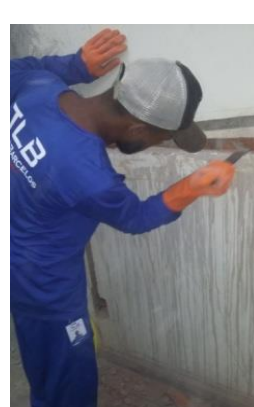
Figuras 06 e 07: Abertura de rasgo em parede para passagem de mangueira corrugada;
