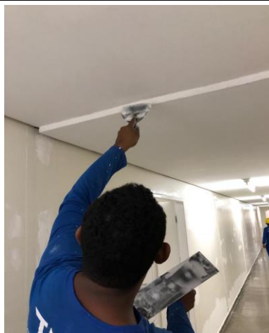
Figura 06: Foi feito o acabamento no gesso com a utilização de massa pva.
