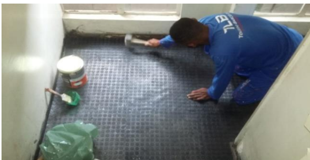
Figuras 03: Instalação do piso moeda na escada da diretoria;
