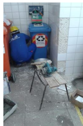
Figuras 03 e 04: Substituição de revestimentos quebrados no abrigo de resíduos;
