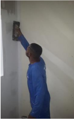
Figura 08 e 09: Aplicação de massa pva na sala do TI;
