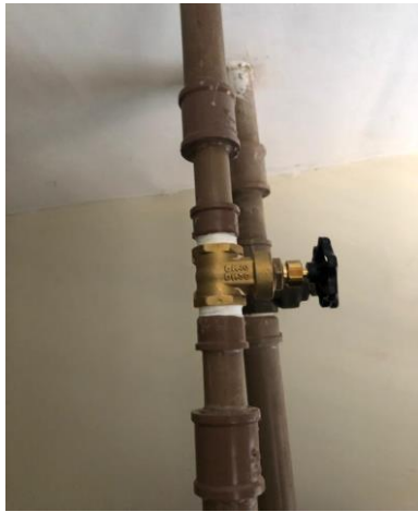
Figura 06: Após identificar que o registro do sistema extravasador estava danificado, foi feita a troca da peça e problema foi solucionado;
