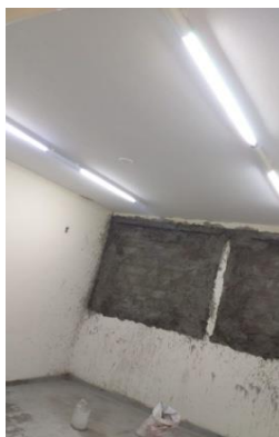
Figuras 01 e 02: Reinstalação do circuito de iluminação, e troca do sentido das luminárias;
