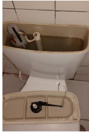
Figura 07: Ajuste em caixa acoplada do banheiro feminino de doadores.
