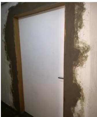
Figura 01: Acabamento com argamassa em portal assentado;
