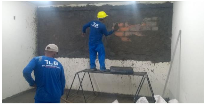
Figura 01: Reboco de alvenaria de fechamento;
