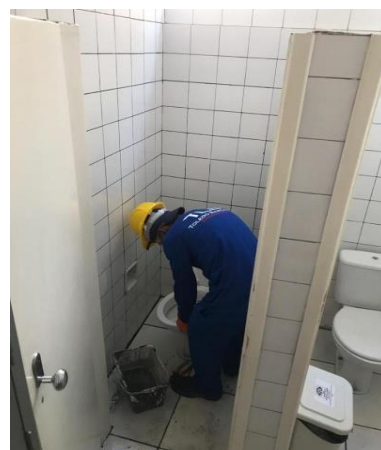
Figura 06: Vaso sanitário foi desentupido;
