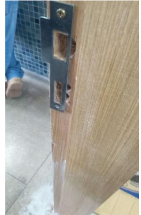
Figura 09 e 10: Descarte de portais e demais madeiras inutilizadas; Ajuste em fechadura.
