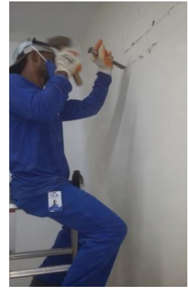
Figura 11 e 12: Abertura de rasgo para passagem do dreno do ar condicionado..
