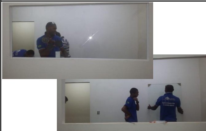
Figuras 01 e 02: Instalação de vidro temperado 8mm na sala do TI;
