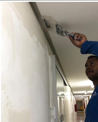
Figura 05: Fechamento de abertura no gesso com a utilização de gesso em pó;
