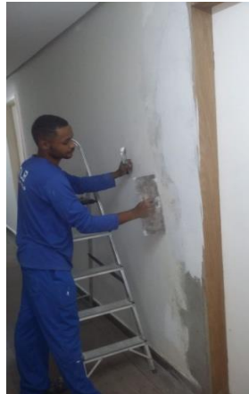
Figura 07 e 08: Aplicação de massa pva na sala do TI;
